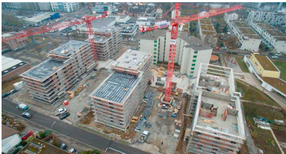
Blick vom Sulperg auf die Grossbaustelle «Sulperg-2.»
